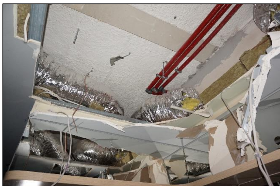
Uszkodzenia po kradzieży - wyrwana tablica elektryczna, kradzież rur miedzianych
