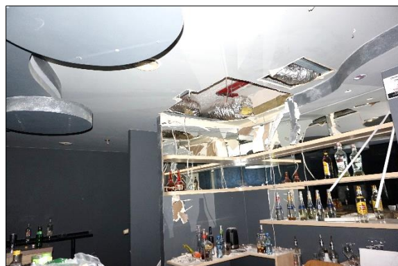
Sala konsumencka - Bar - uszkodzenia w suficie
