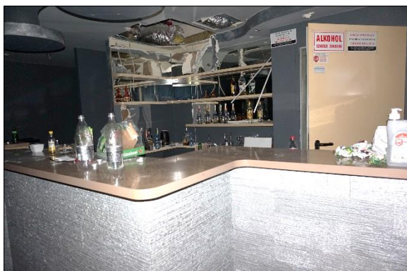
Sala konsumencka - Bar - uszkodzenia w suficie
