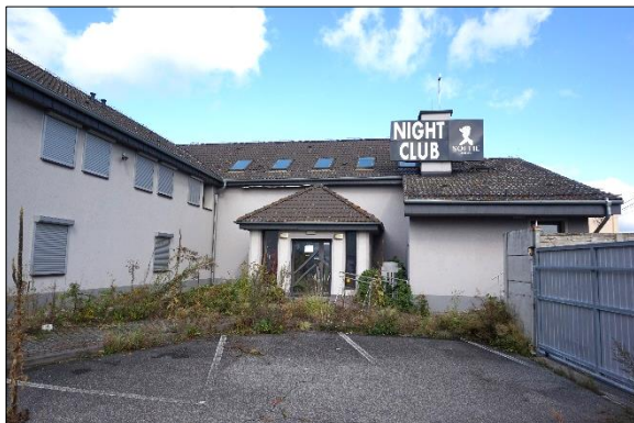
Widok na budynek od strony parkingu
