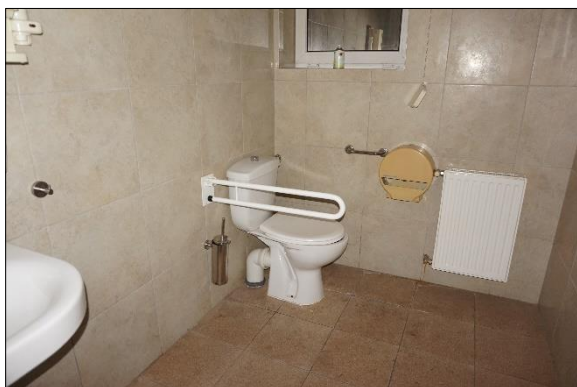
Toaleta dla niepełnosprawnych
